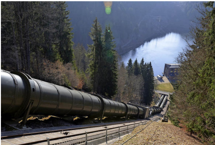
Pumpspeicherkraftwerk Häusern Foto: Barthmes
